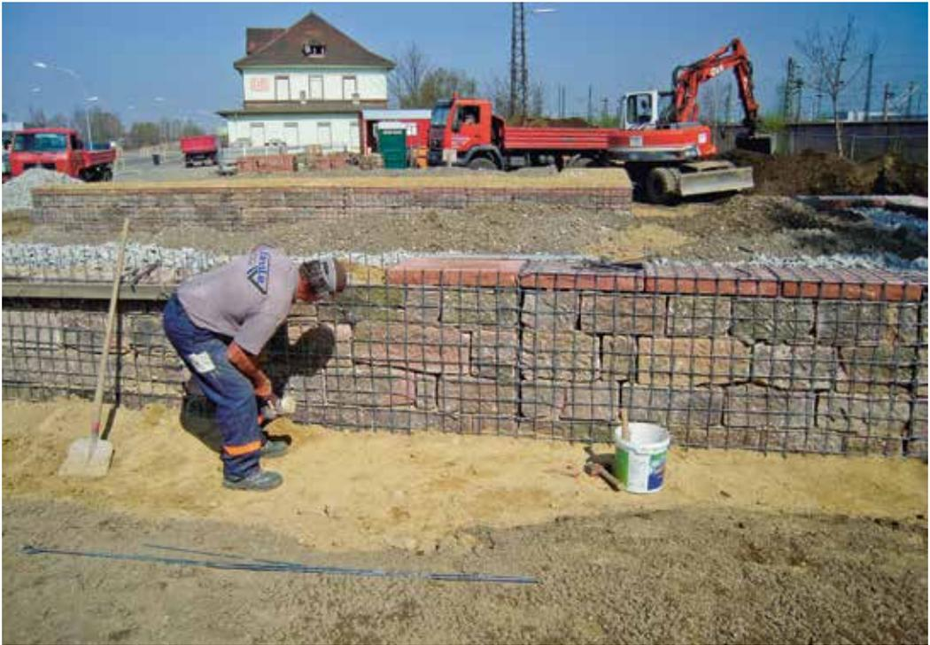
*Bau einer Trockenmauer als neuer Lebensraum für die Mauereidechse. Hinter der Sandsteinmauer befindet sich eine Steinschüttung (Winterquartier) und am Mauerfuß grabbares, nährstoffarmes Substrat als Eiablageplatz. Das Drahtgeflecht hat nur Schutzfunktion, um das unerlaubte Entfernen der Steine zu unterbinden.*
