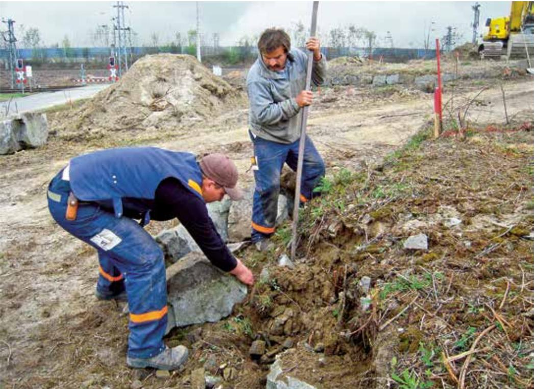
Ein von Mauereidechsen besiedelter Blocksatz wird schonend von Hand rückgebaut, um keine Eidechse zu töten. Der Rückbau kann nur innerhalb der Aktivitätsperiode und außerhalb der Fortpflanzungszeit durchgeführt werden.
