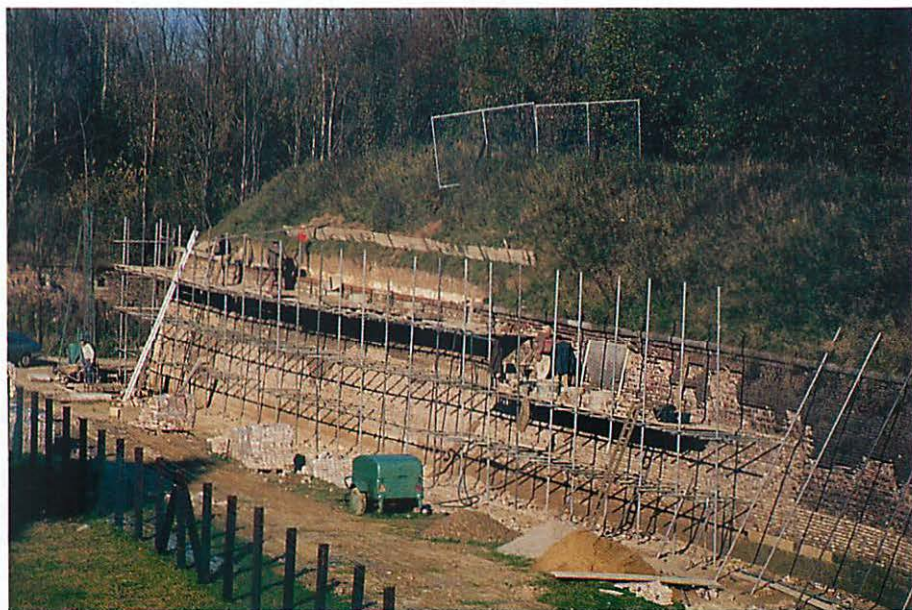
Grootschalige restauratie van de muren van de Hoge Fronten in 1980. Foto: B. Kruyntjens.
