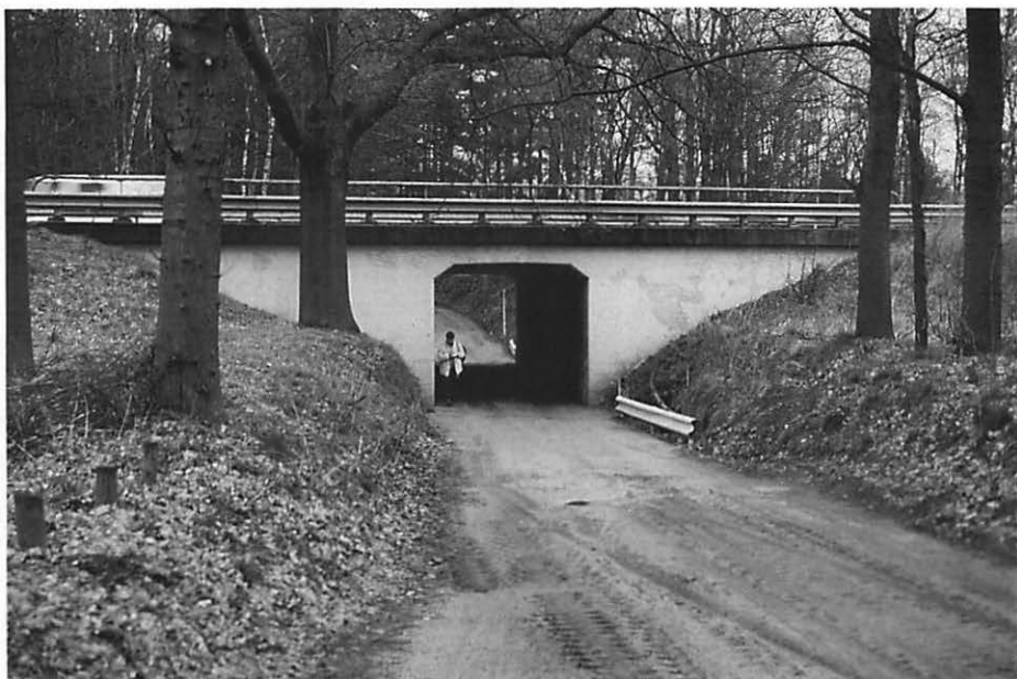
Tunneltje onder de A12 bij EDE. Aan beide zijden van de tunnel leven zandhagedissen, levendbarende hagedissen en hazelwormen. Foto: A. Zuiderwijk.
