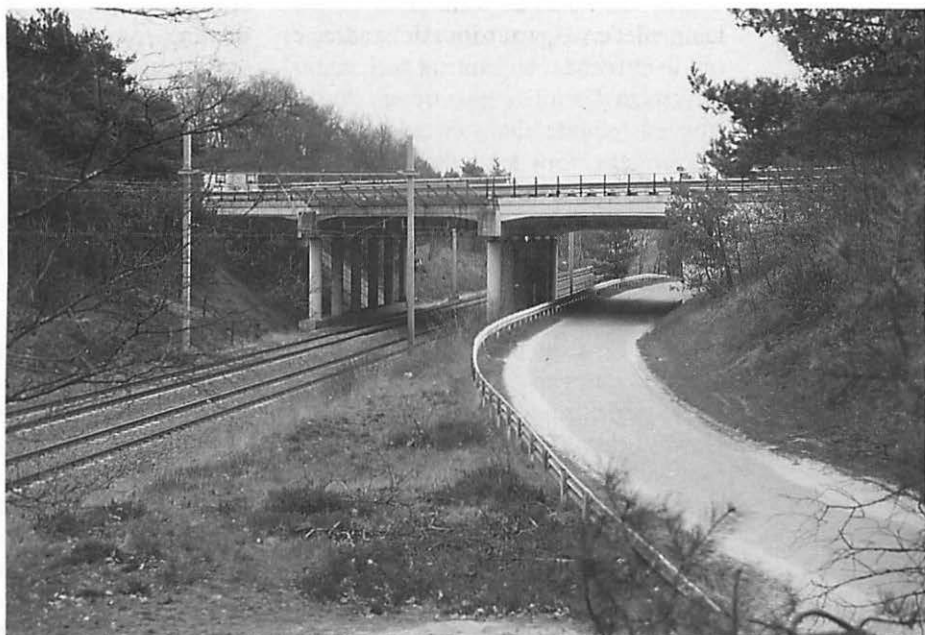
Spoorviaduct onder A12; de bermen functioneren hier als een snelweg-passagie voor hagedissen. Foto: A. Zuiderwijk, 1988.
