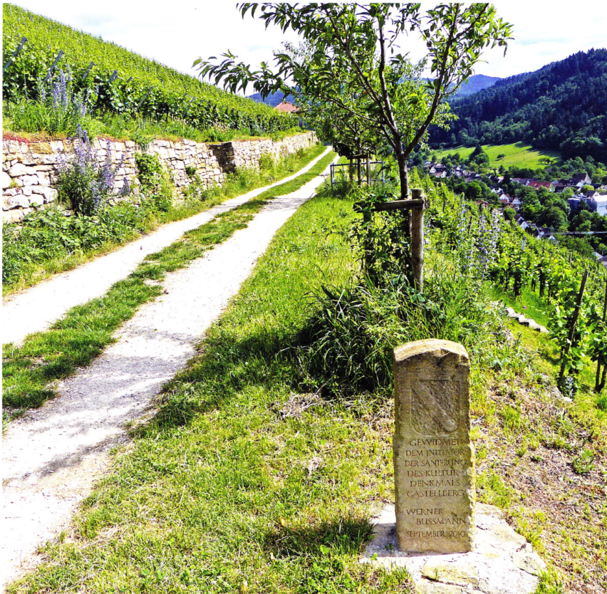
Abb. 2: Eine der am Weg gelegenen sanierten Rebmauern im Untersuchungsgebiet. (Foto: Tobias Hohlfeldt)
