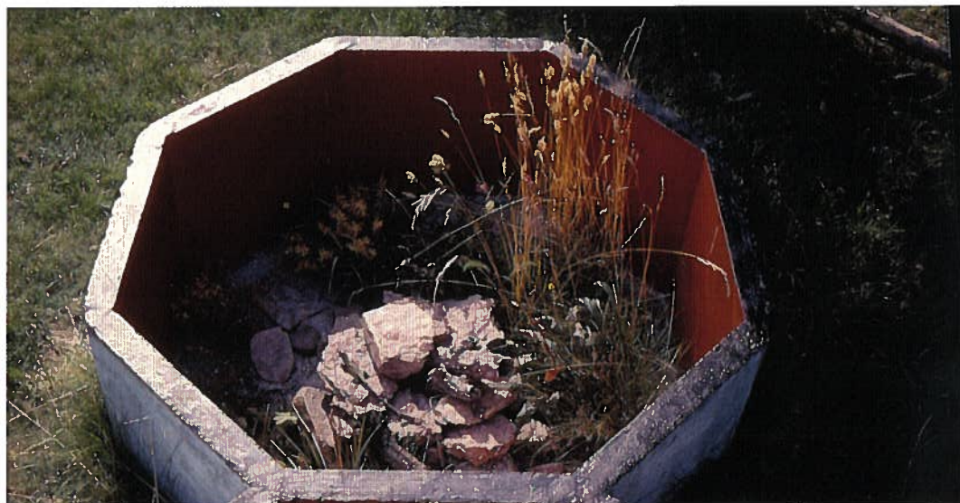
Redaktørens frilandsterrarium hvor ruinfirben og platysaurus havde sommerophold. Terrariet var lavet af fliser (40x40cm), stillet på højkant, oven på et støbt fundament. Fliserne var malet med oliemaling på indersiden og var derfor så glatte at dyrene ikke kunne undvige. Terrariet fungerede upåklageligt i en del år. Foto: Jan Clausen.
