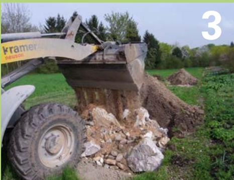
Kiesschüttungen und Bruchsteine mit unbehandeltem, sauberem Material (kein Bauschutt), auch der Einbau von Wurzelstubben ist möglich.
