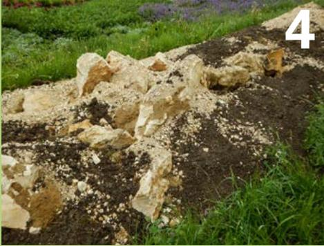
Grobes Material wird mit feinerem Material verfüllt. Der Oberboden wird in den Randbereichen wieder eingebaut.
